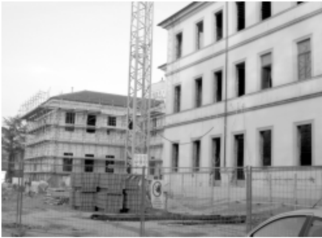
Lavori all'ex Allegretto nuova sede del Comune
